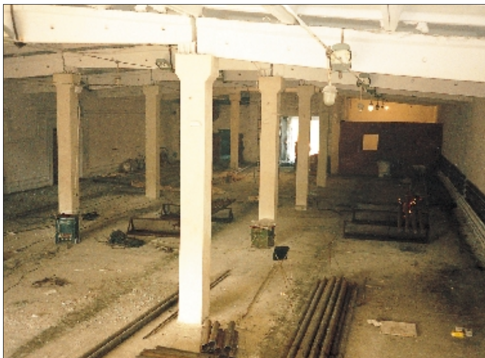
Реконструкция торгового павильона №1 начинается.
