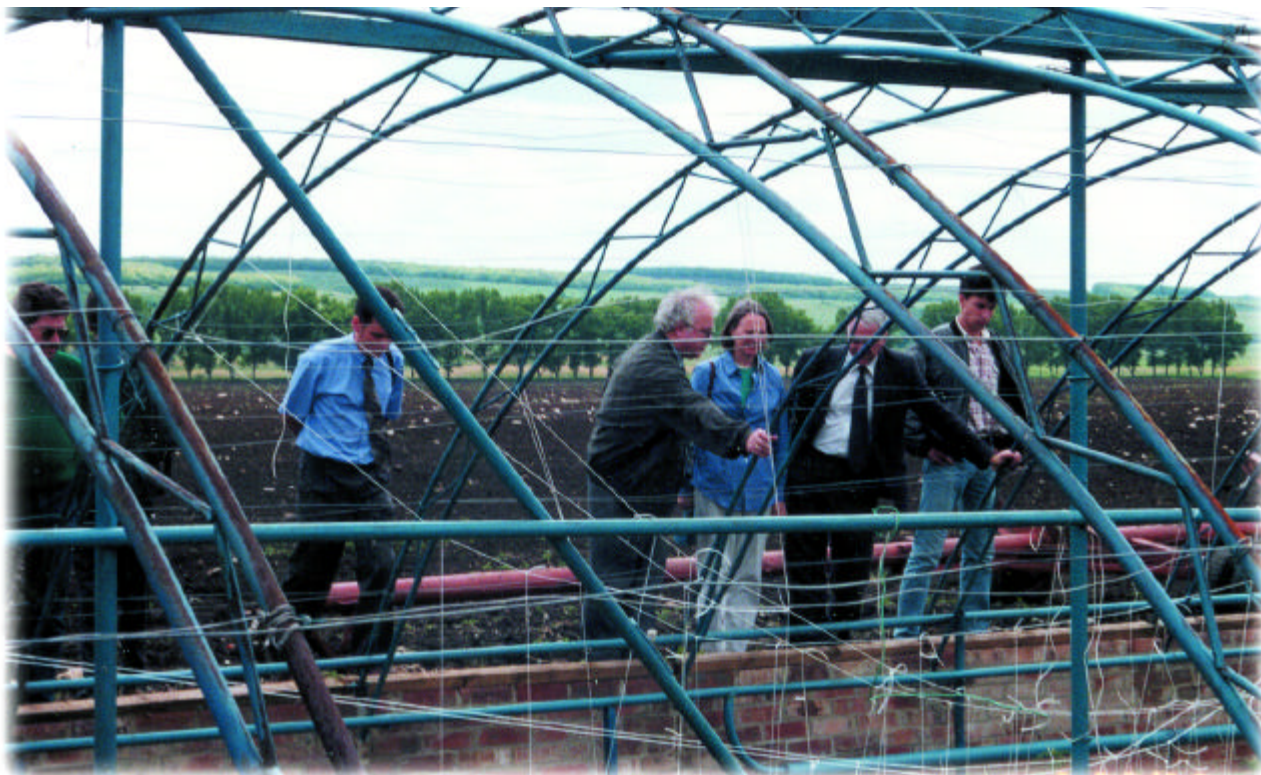
Работа с фермерами по сооружению экономичной теплицы. Однако эксперты проекта считали необходимым больше использовать уже существующие постройки.
